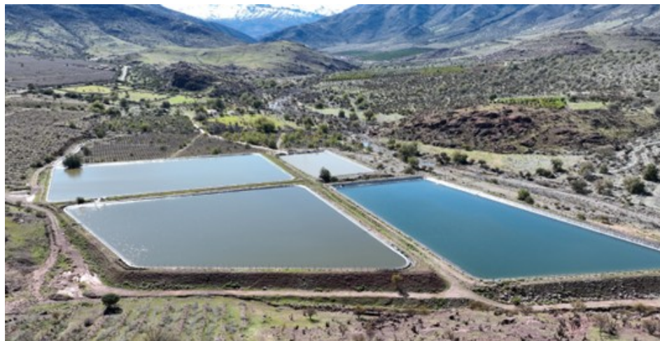
FIGURA 2. Piscinas de acaparamiento del agua agronegocio, sector de Calle Larga, Petorca Fuente: Elaboración propia.
