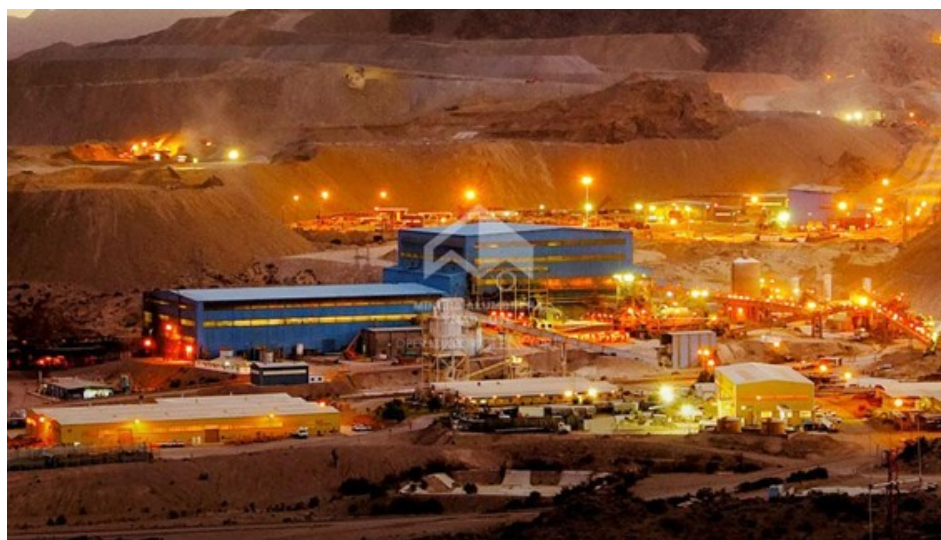
FIGURA 1. Planta Concentradora e instalaciones complementarias en la mina
