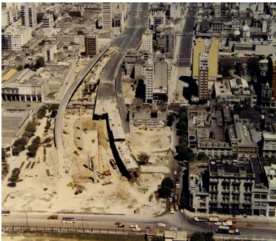
FIGURA 7. Construcción de la autopista en el casco histórico. La imagen muestra los trabajos de construcción de la autopista Sur (actual 25 de Mayo), en la manzana formada por Paseo Colón, San Juan, Huergo y Cochabamba, donde funcionó el ex centro clandestino de detención, tortura y exterminio Club Atlético. El edificio de la Policía Federal fue demolido a finales de la década de 1970. Fuente: Archivo Histórico de AUSA. Proyecto de Recuperación de la Memoria Centro Clandestino de Detención y Tortura Club Atlético. Archivo histórico del Programa Recuperación de la Memoria del Centro Clandestino de Detención.
