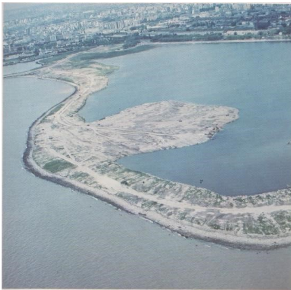
FIGURA 6. Relleno en la Costanera Sur
