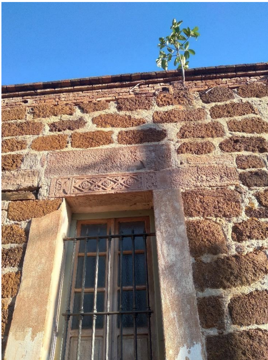
FIGURA 4. Casa de piedra ubicada frente a la plaza principal del pueblo. Se pueden observar sillares reutilizados y un dintel con decoración
