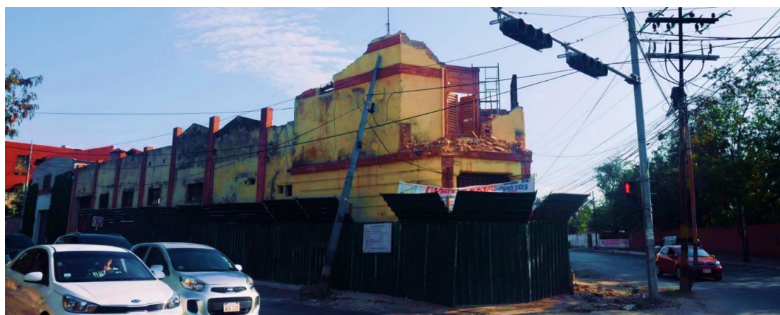
Figura 3: CHA, Molino San Luis en proceso de demolición. Setiembre de 2022
