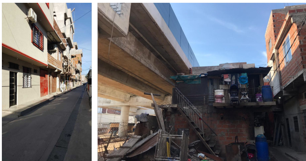
FIGURA 2. Frente de viviendas y viviendas limitantes con las vías del ferrocarril
