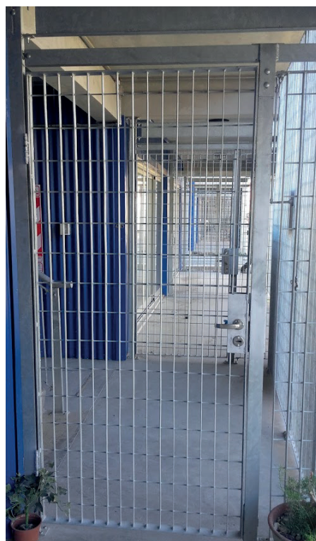
Figura 5. Vista de las expansiones del Conjunto Containera Azul.
