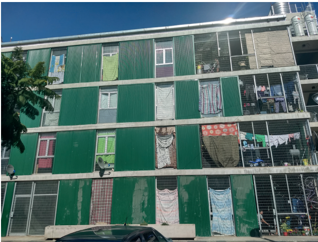
Figura 6. Vista de las fachadas con barreras protectoras de la privacidad.
