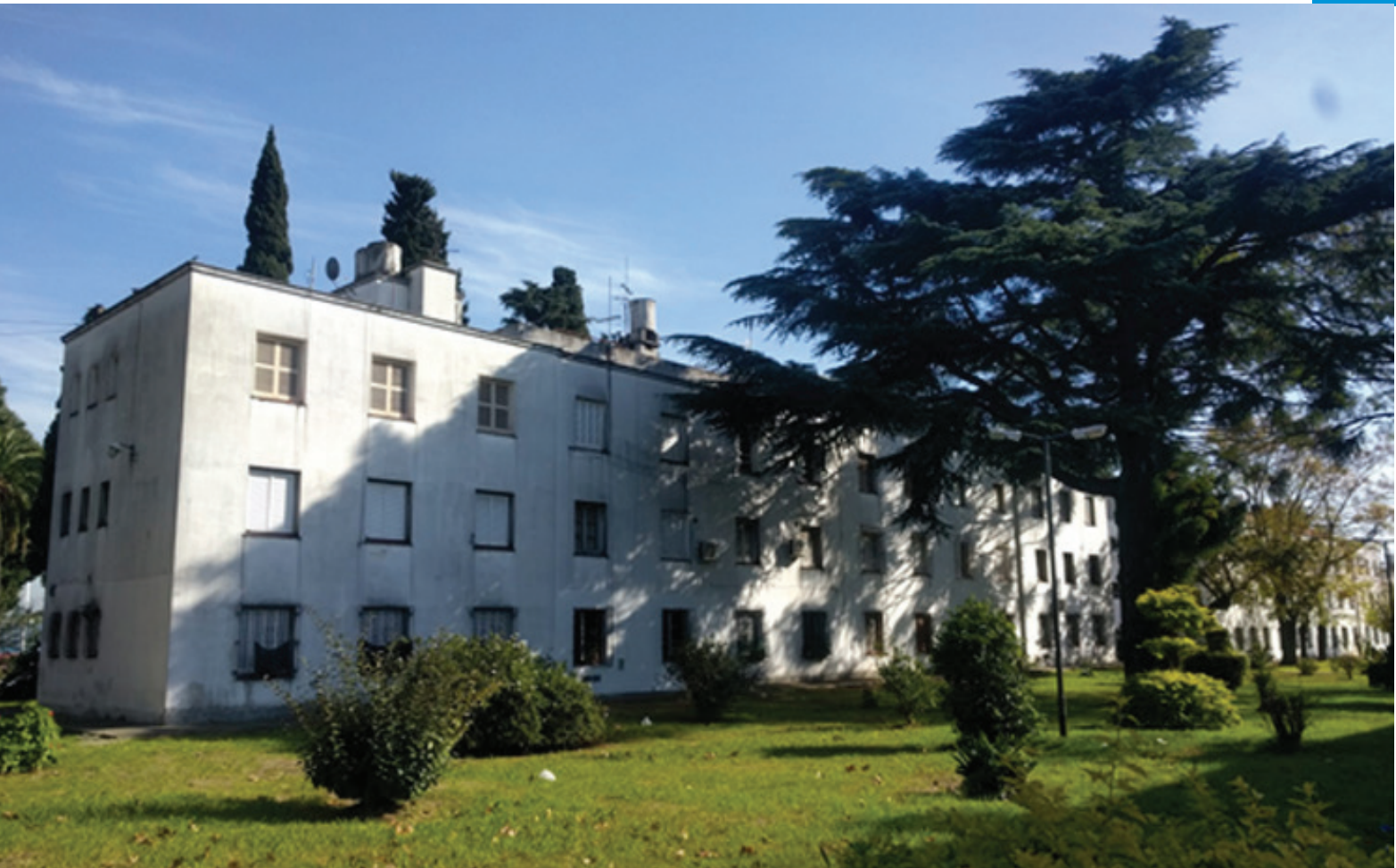
Conjunto Habitacional Los Perales. 1068 Viviendas. Año 1949.
