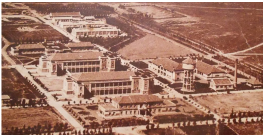
Fig. XI. Guarnición Militar en Bahía Blanca, en construcción, 1917.
