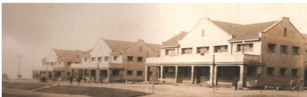
Fig. XIII. Vista frontal de los pabellones de tropa en el cuartel de Paso de los Libres, Corrientes, 1936, de acuerdo a la “Cuadra Modelo 1934”.
