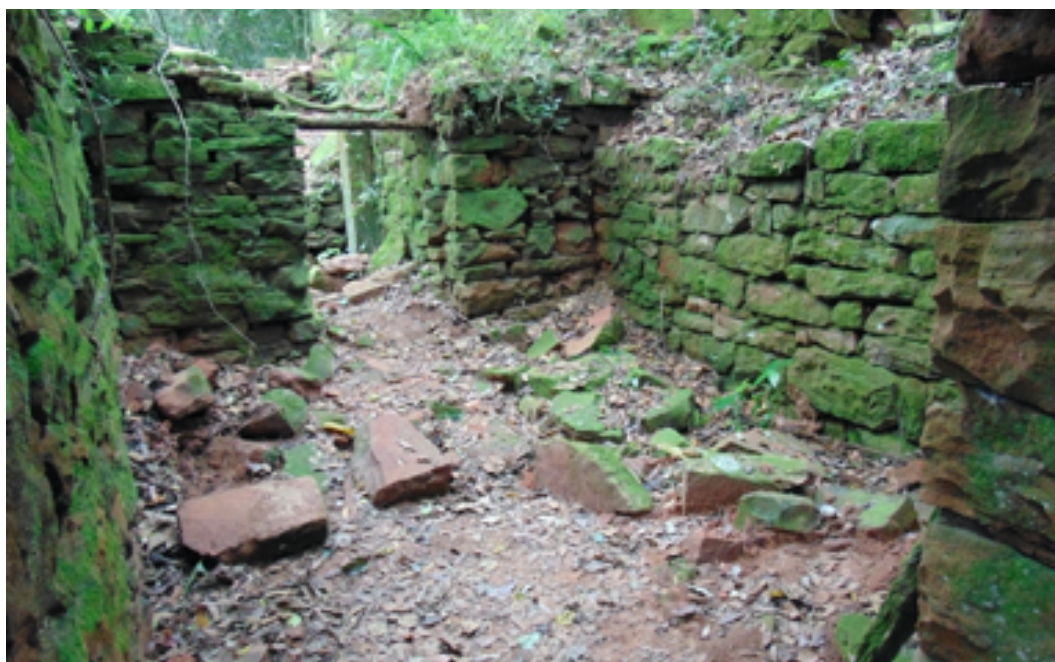
Figura III. Vista interna de una de las habitaciones de otro de los edificios que aún se mantiene en pie.
